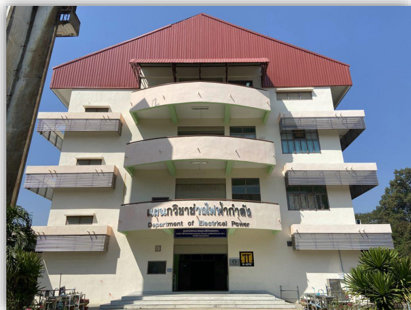
อาคารแผนกวิชาช่างไฟฟ้ากำลัง
